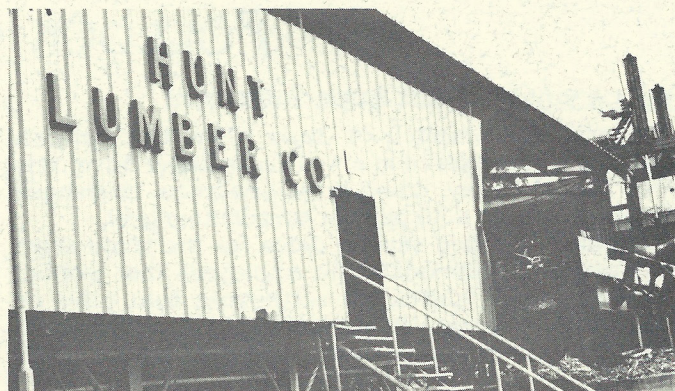
OLLA MILL RENOVATIONS
